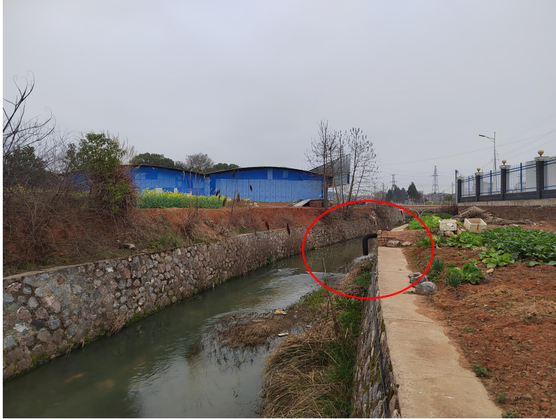
图 5.4-1 “祁东县白地市镇污水处理工程”总排口现状
