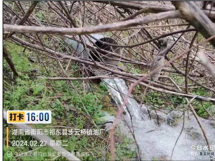
图 5.4-1 “祁东县步云桥镇污水处理工程” 总排口现状
