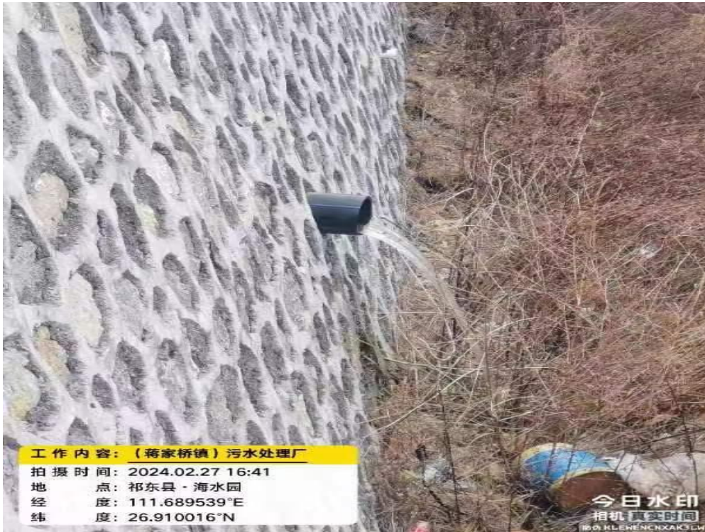
图 5.4-1 “祁东县蒋家桥镇污水处理工程”总排口现状
