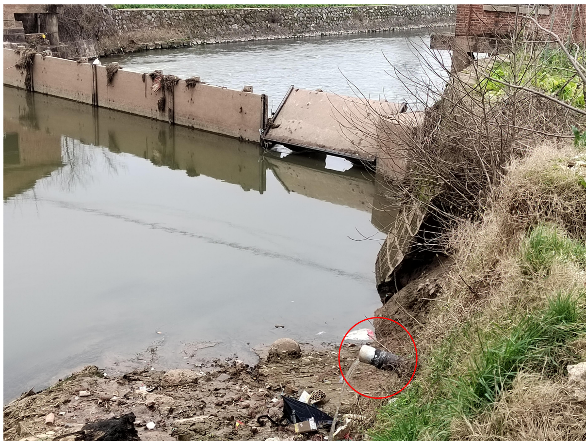
图 5.4-1 “祁东县金桥镇污水处理工程”总排排口现状
