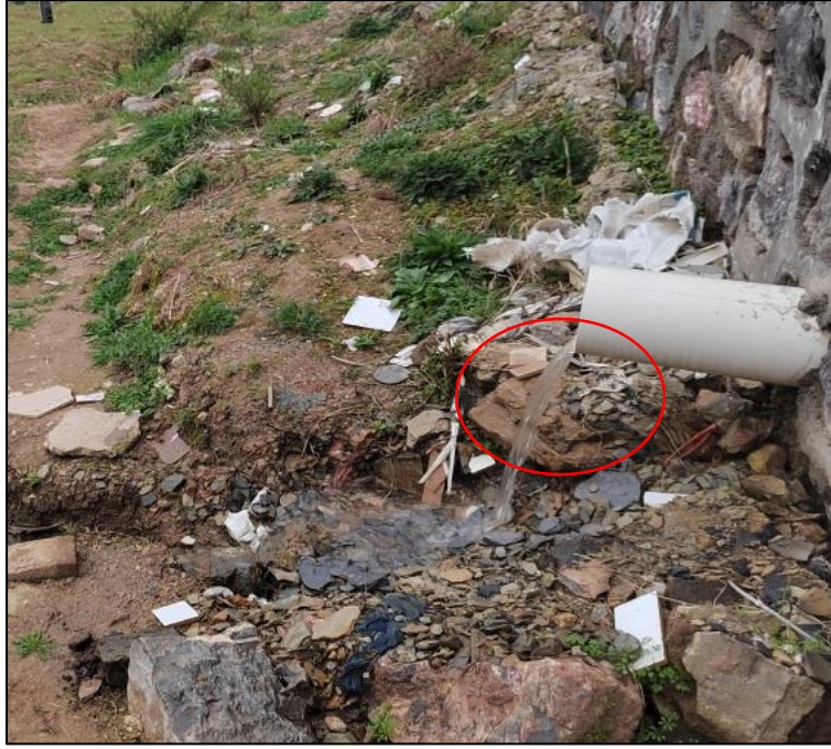
图 5.4-1 “祁东县风石堰镇污水处理工程” 总排口现状
