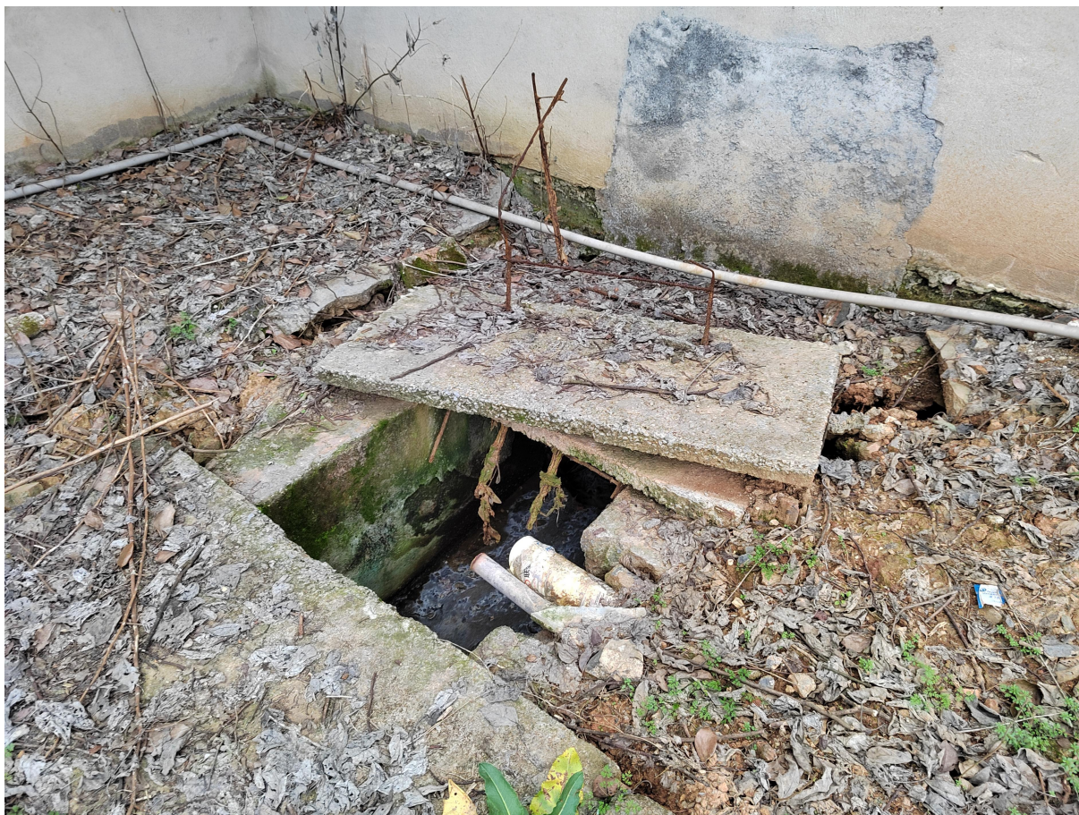
图 5.4-1 “祁东县双桥镇污水处理工程”总排口现状
